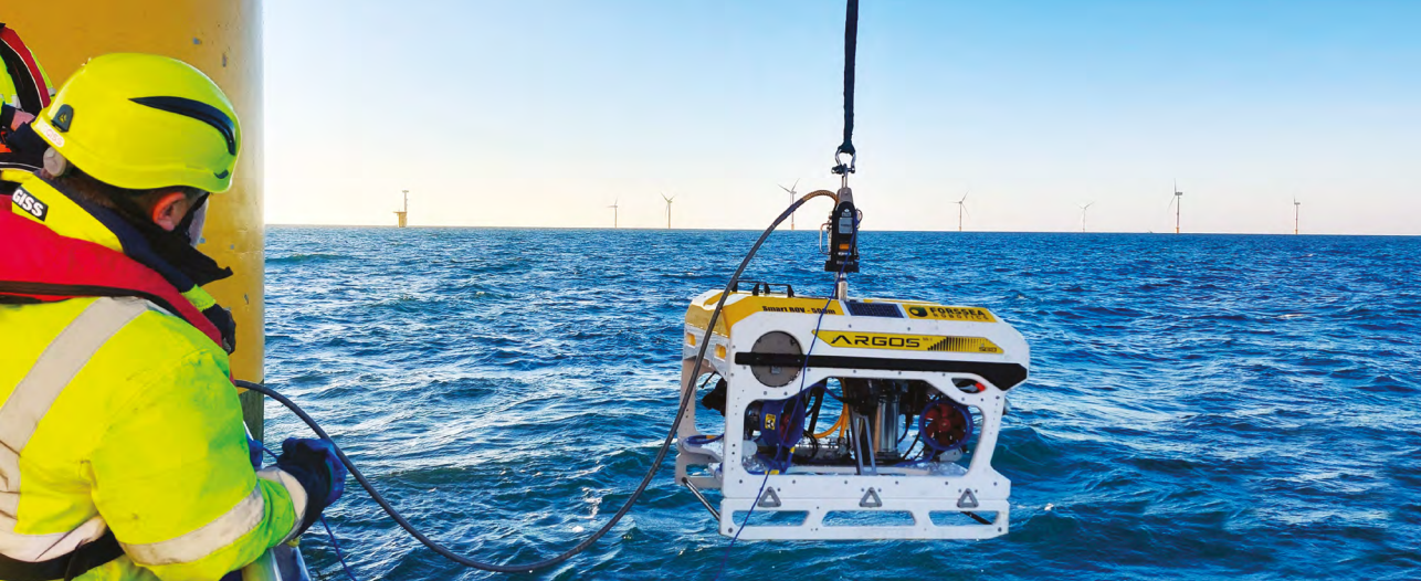
Inspection éoliennes site EDF, FECAMP, Juillet 2024 © : Argos
